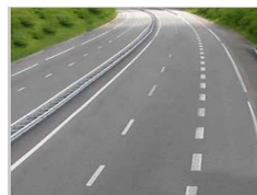
Une autoroute en goudron
