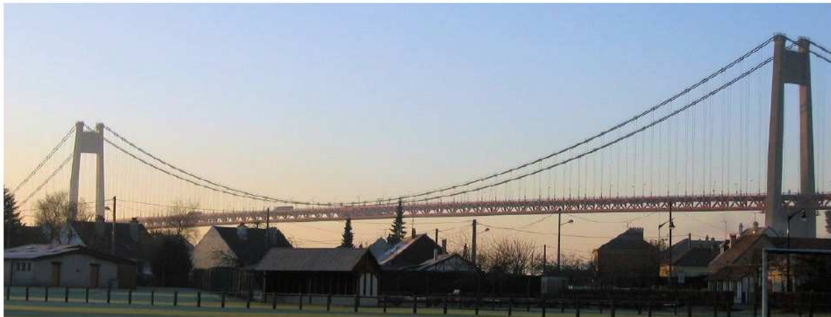
Le pont de Tancarville est un pont suspendu qui enjambe la Seine entre Tancarville (Seine-Maritime) et le Marais-Vernier (Eure). Commencé en 1955, il a été mis en service en 1959. Il possédait la plus longue travée centrale d'Europe, 608 mètres.
