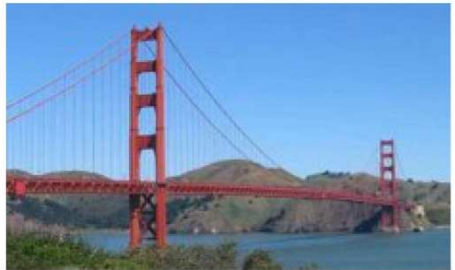
Le Golden Gate Bridge à San Francisco (États-Unis), commencé en 1917 et achevé en 1937 . Il mesure 1 970 m de long, la distance entre les deux tours principales est de 1 280 m et leur hauteur de 230 m au-dessus du niveau de l'eau.
