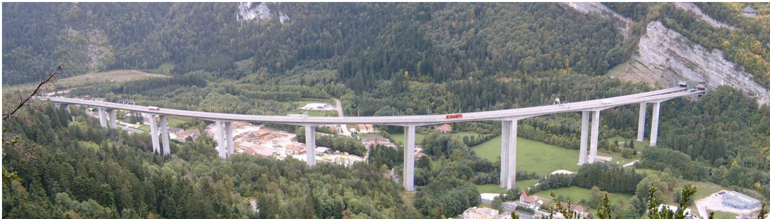
Viaduc de Nantua, ouvrage sur l'A40, inauguré en 1988.
