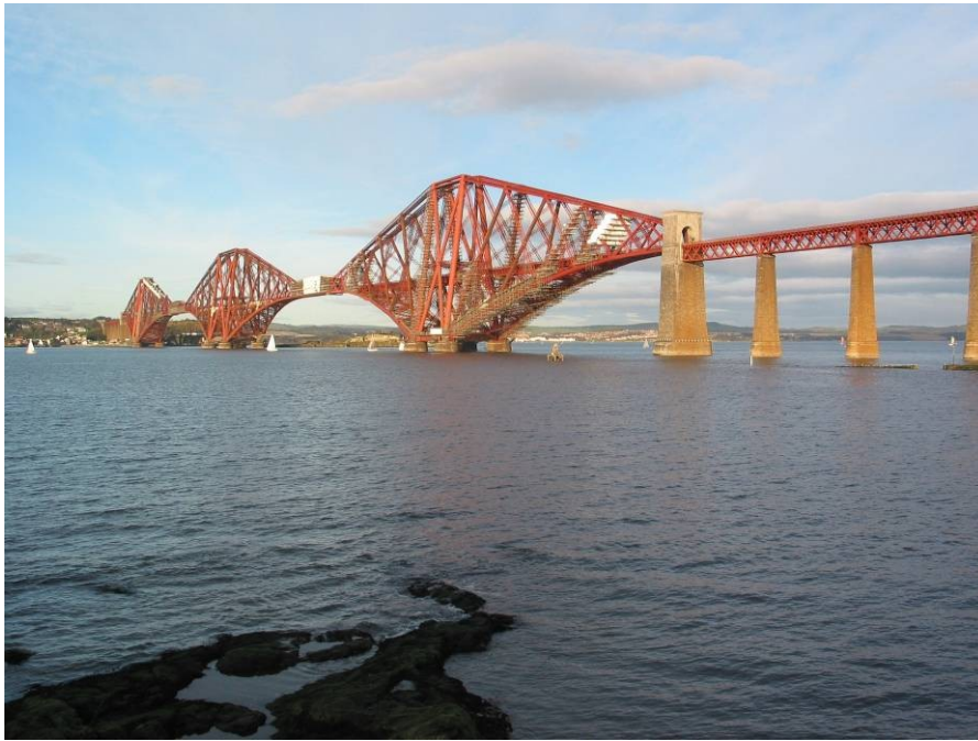
Pont du Firth of Forth (Écosse), réalisé en 1890, avec deux travées de 521 mètres.
