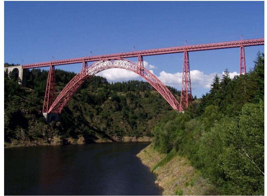
Pont viaduc de Garabit (Cantal), achevé en 1884, avec une portée de 165 mètres.
