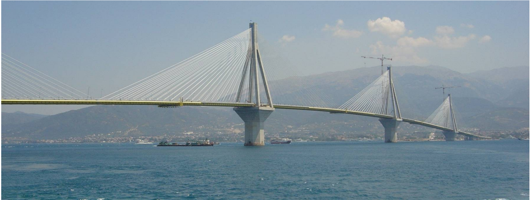
Pont de Rion-Antirion, mis en service en 2004, d'une longueur totale de 2880 m, avec des portées de 286 m et 560 m.
