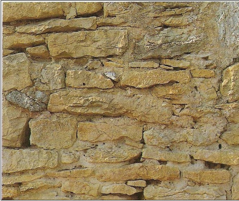
Un mortier de terre assure le calage; appareillage calcaire dans le Nord-Dauphiné
