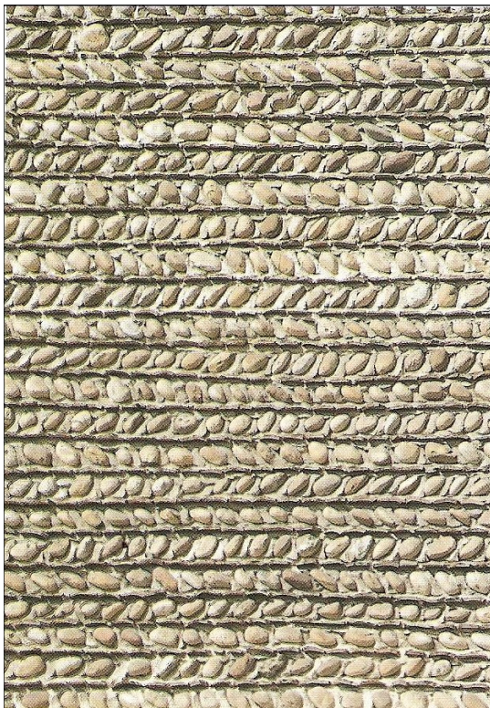
Façade entièrement en galets organisés en arêtes de poisson à Chasselay.
