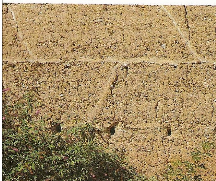
Détail de montage du pisé à Arcis.
